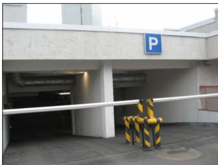
Въезд в подземную стоянку отеля. 2015 г. Фото О.А.Макаровой.
